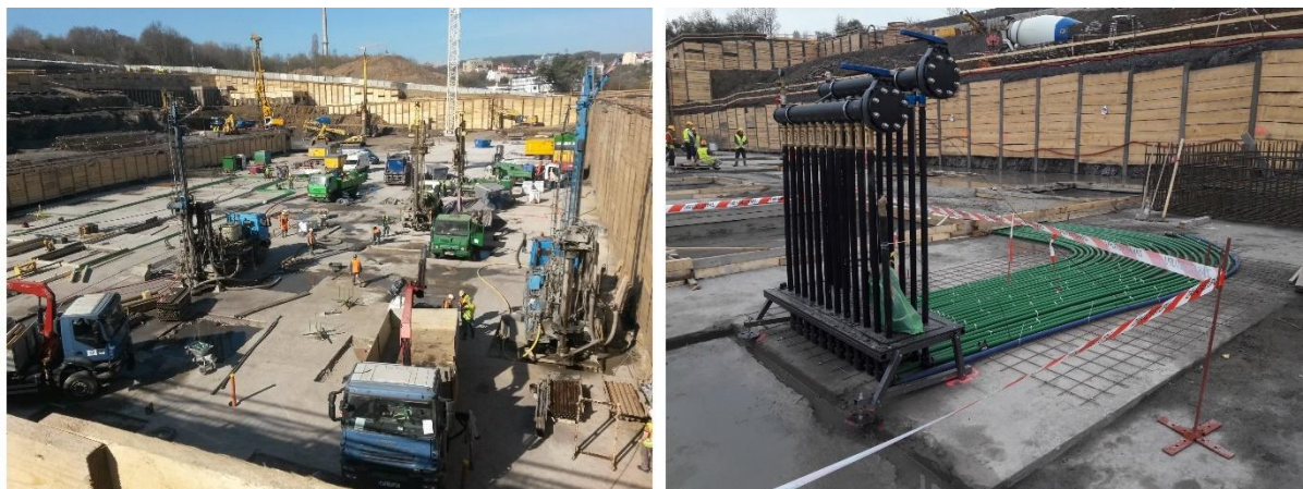
Obr. 2 Realizace vrtného pole a propojení vrtů do primárního okruhu. Fig. 2 Construction of a borehole field and connection of boreholes into the primary circuit.
